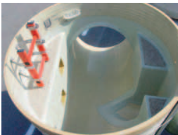
Фото 4-4-1 Вид плиты основания и оборудования
