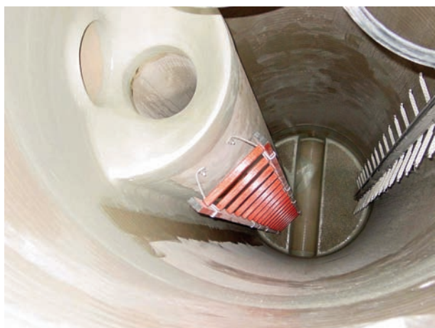
Фото 4-5-1 Смотровый колодец с внутренним задником
